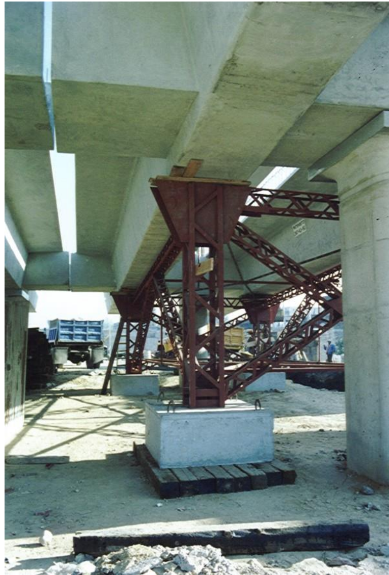
Fotografía 3: Apuntalamiento temporal en puente vehicular.
