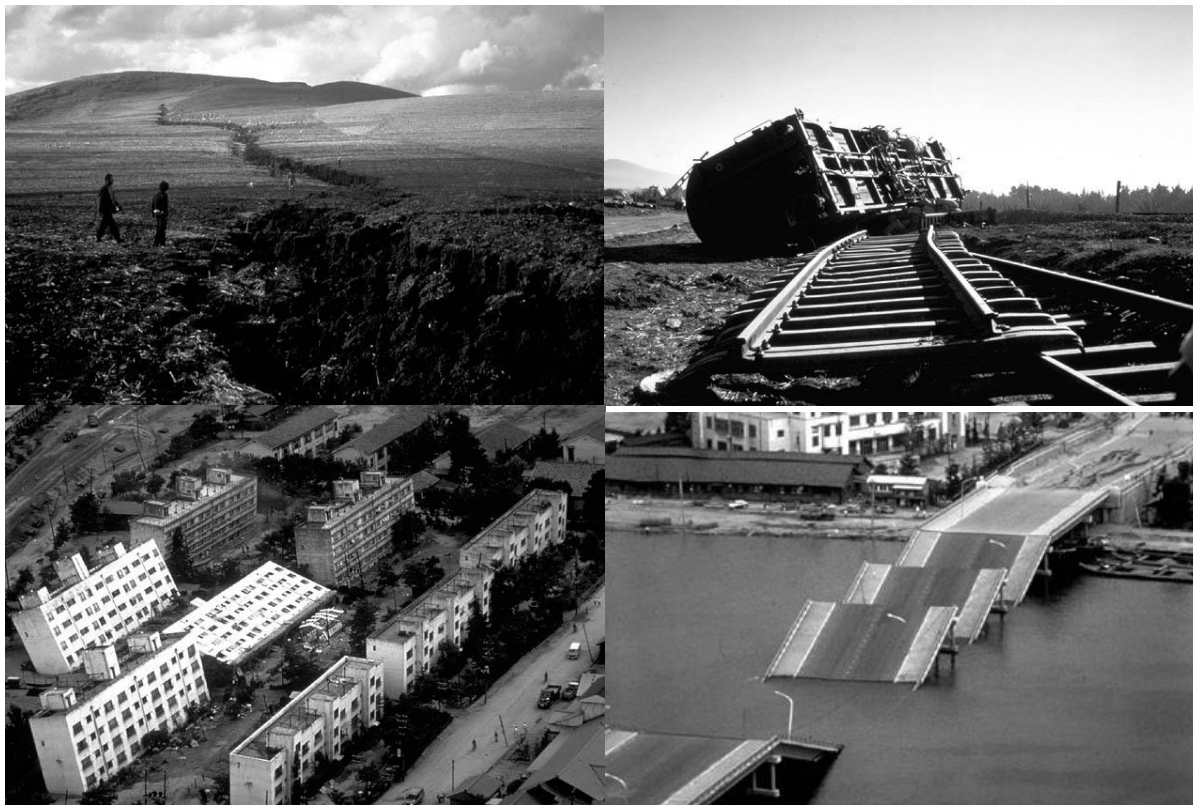
Fig. 4 Fallas en el suelo y estructuras ( www.eerc.berkeley.edu/bertero ).
