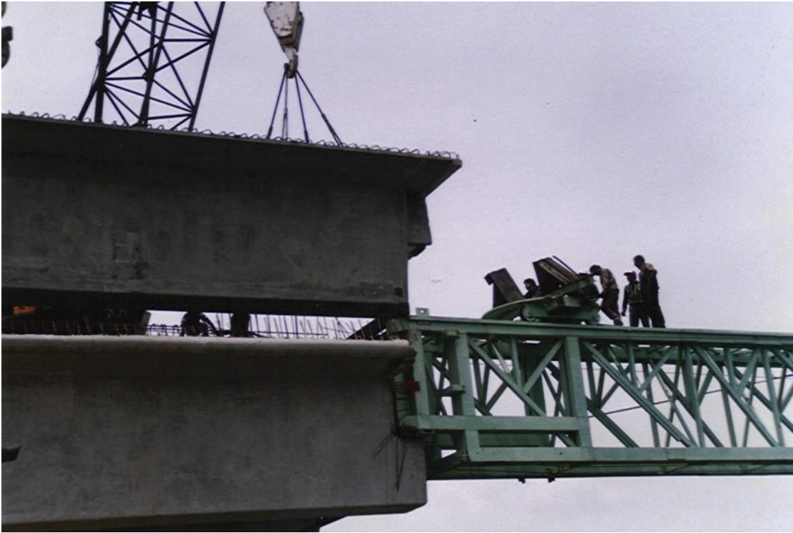
Fotografía x: Cargas temporales durante el montaje de un puente vehicular. Grúa, estructura de montaje y trabe
