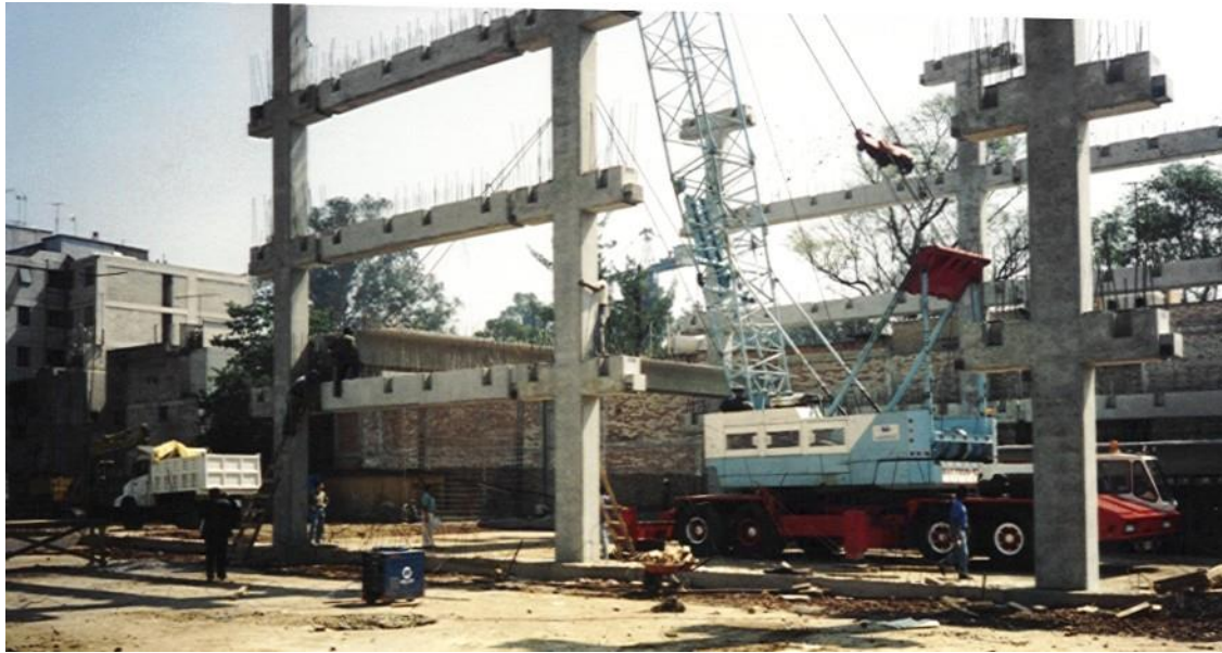
Fotografía 1: Las estructuras prefabricadas deben contar con contraventeos temporales.
