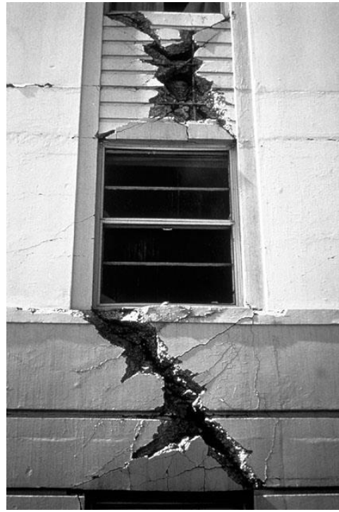
Fig. 5 Fallas en estructuras prefabricadas, acabados, y trabes entre muros de concreto ( www.eerc.berkeley.edu/bertero ).
