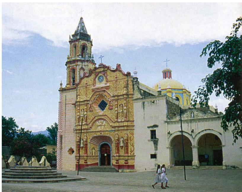
FIGURA 3. Misión de Jalpan, Querétaro. Nótese el reloj en la fachada que sustituyó a un relieve original destruido por los sismos.
