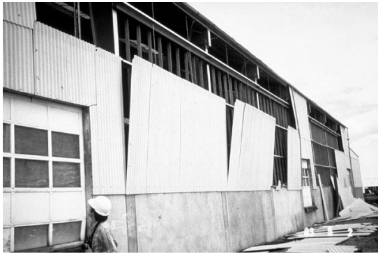
Fig. 5 Fallas en estructuras prefabricadas, acabados, y trabes entre muros de concreto ( www.eerc.berkeley.edu/bertero ).
