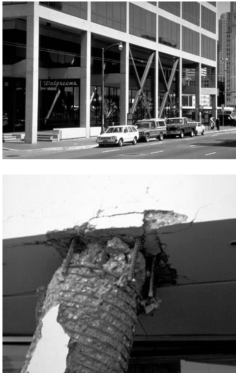
Fig. 7 Reforzamiento en estructuras de planta flexible, defecto constructivo en el detallado de la terminación de la espiral y modelo a escala para prueba de laboratorio ( www.eerc.berkeley.edu/bertero ).
