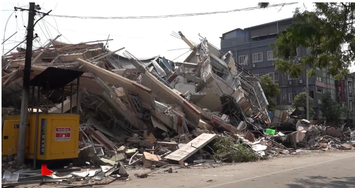
Figura 3.19. Efecto de la amplificación de la onda sísmica de la roca basal a la superficie del terreno, colapso de un edificio en Mandalay ( https://en.wikipedia.org/wiki/2025_Myanmar_earthquake#/media/File:2025_Myanmar_earthquake_damage_in_Mandalay_(1).png )
