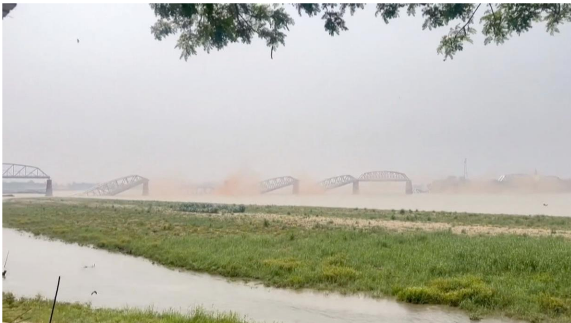
Figura 6.5. Imagen tomada justo en el momento del colapso del puente Ava.
