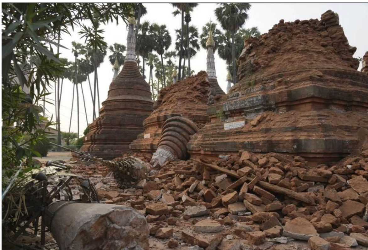
Figura 7.1. Daños en el monasterio Maha Aungmye Bonzan.
