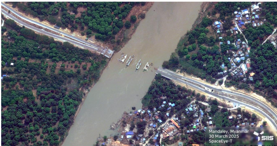
Figura 6.7. Vista aérea del Puente Duthawaddy después de haber colapsado debido al sismo de Myanmar.
