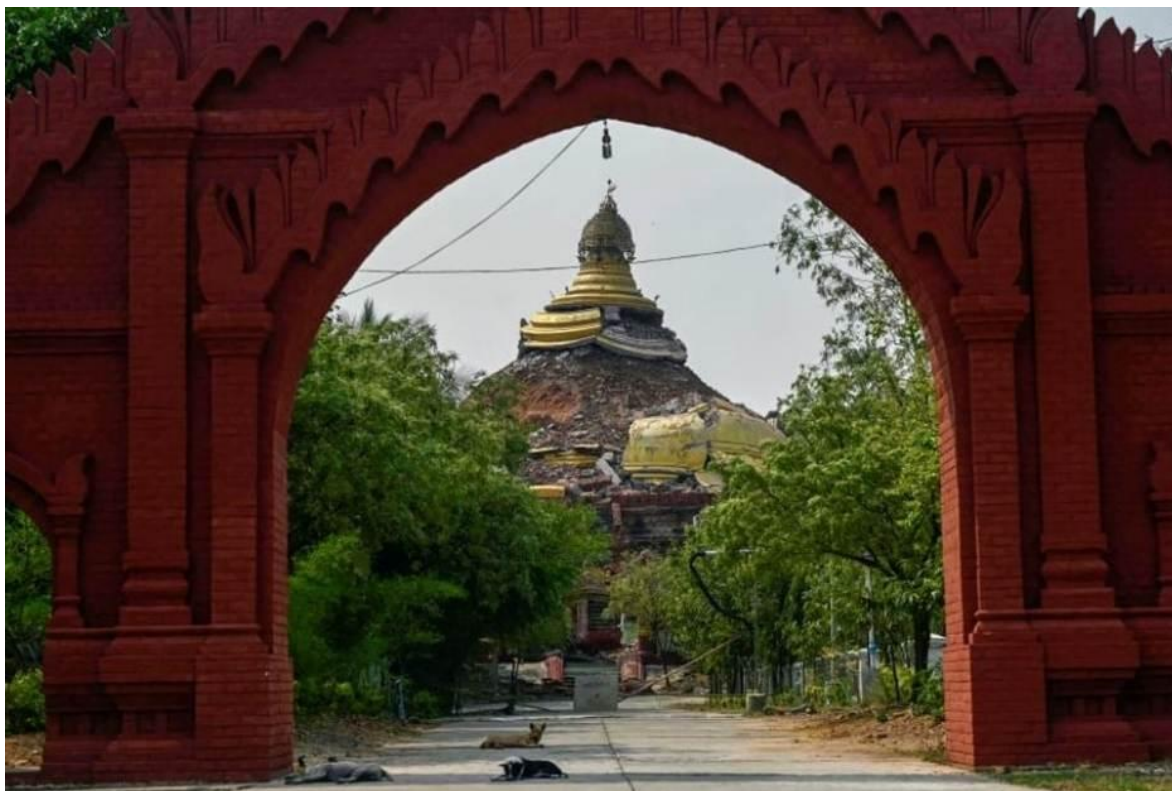
Figura 7.4. Daños en una cúpula.
