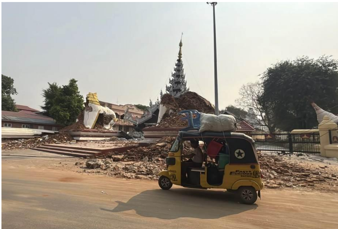
Figura 7.2. Daños en edificio histórico.
