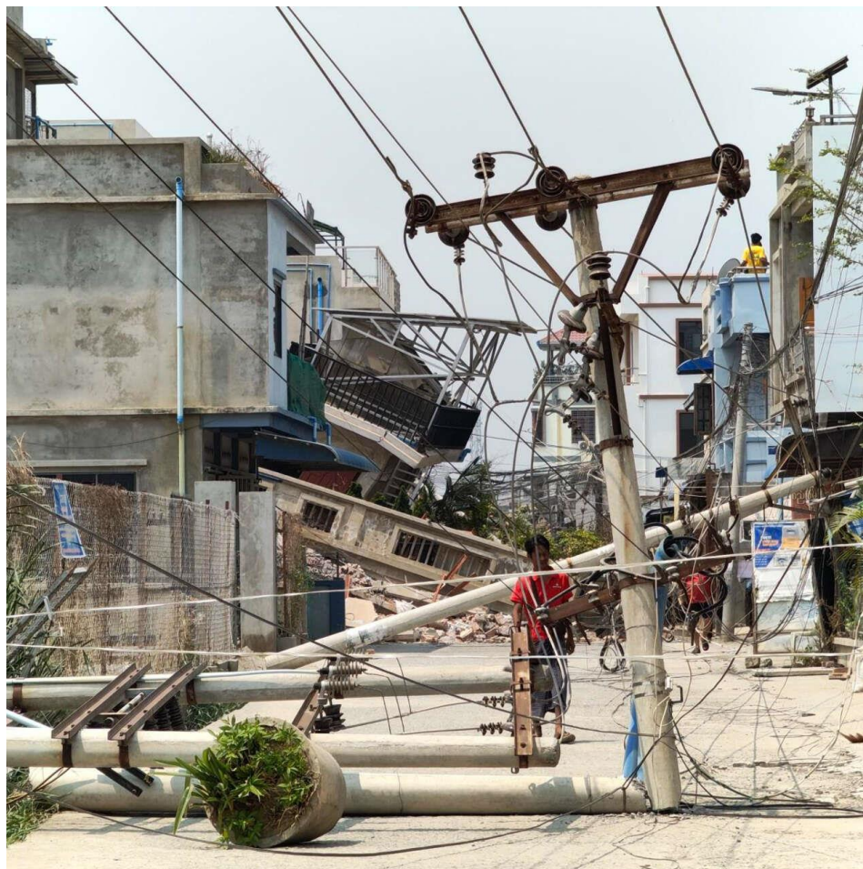
Figura 6.18. Afectaciones en la red eléctrica de Myanmar.
