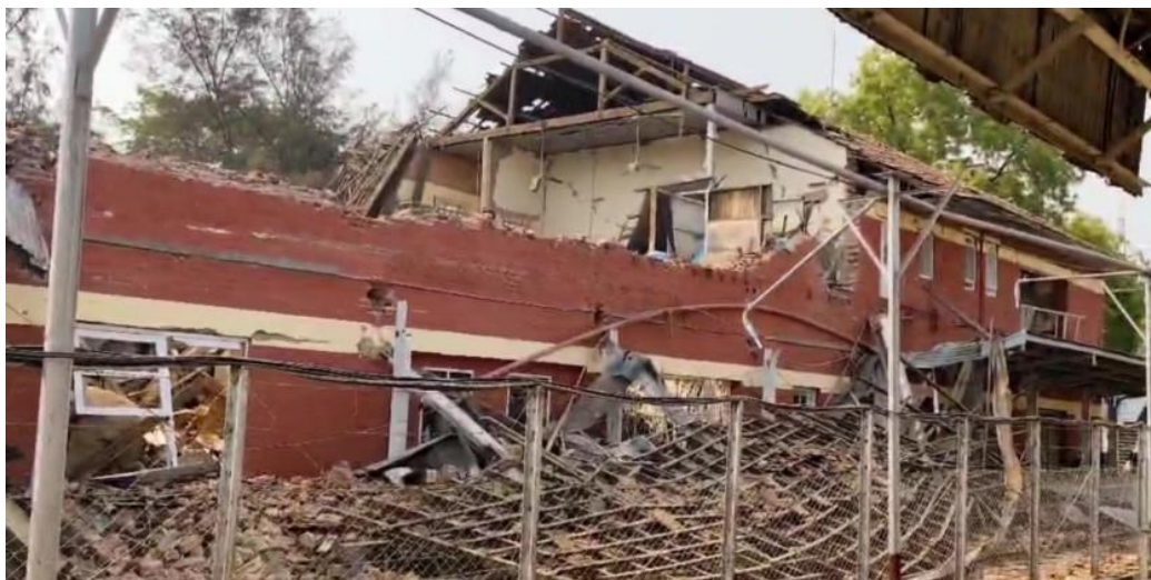
Figura 6.17. Estación de tren con fuertes daños por el terremoto de Myanmar.
