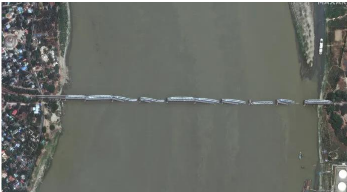
Figura 6.3. Vista aérea del puente Ava después de colapsar.
