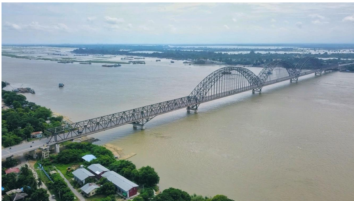
Figura 6.8. El Puente Yadanabon, adyacente al puente Ava sobre el Río Irrawaddy.
