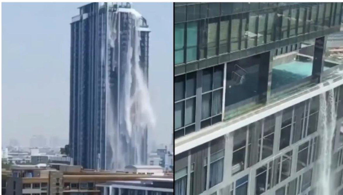
Figura 5.2. Imágenes obtenidas de un video del terremoto captura la piscina infinita de la azotea de Bangkok convertida en cascada
