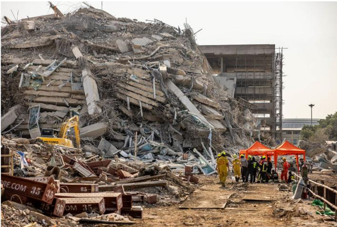
Figura 3.21. Colapso de un edificio en construcción en el área de Chatuchak, en Bangkok, Tailandia, luego del terremoto de Myanmar del 28 de marzo de 2025 (Lauren DeCicca/Getty Images)
