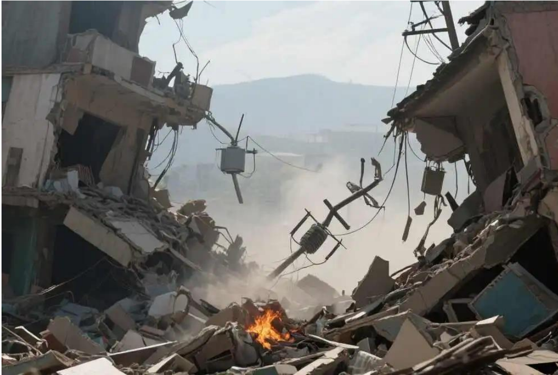
Figura 6.19. Afectaciones severas en la red eléctrica como consecuencia de sismos.
