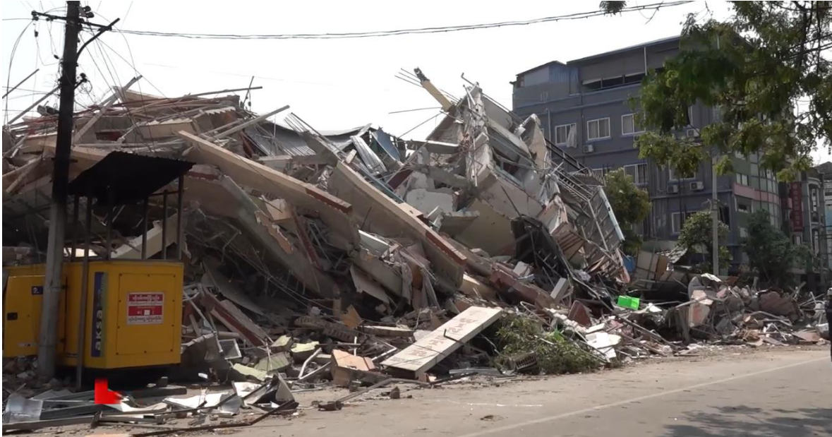
Figura 3.19. Efecto de la amplificación de la onda sísmica de la roca basal a la superficie del terreno, colapso de un edificio en Mandalay
