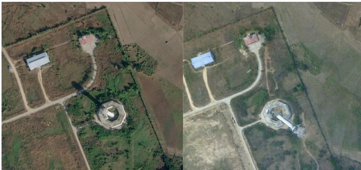
Figura 6.13. Torre de control aéreo del aeropuerto de Naypyidaw antes y después del sismo.
