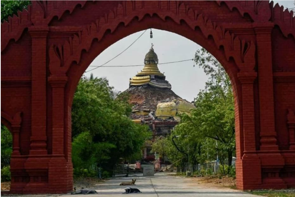
Figura 7.4. Daños en una cúpula.
