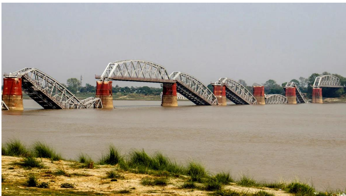
Figura 6.4. Otra vista del puente Ava después de colapsar debido al sismo de Myanmar.
