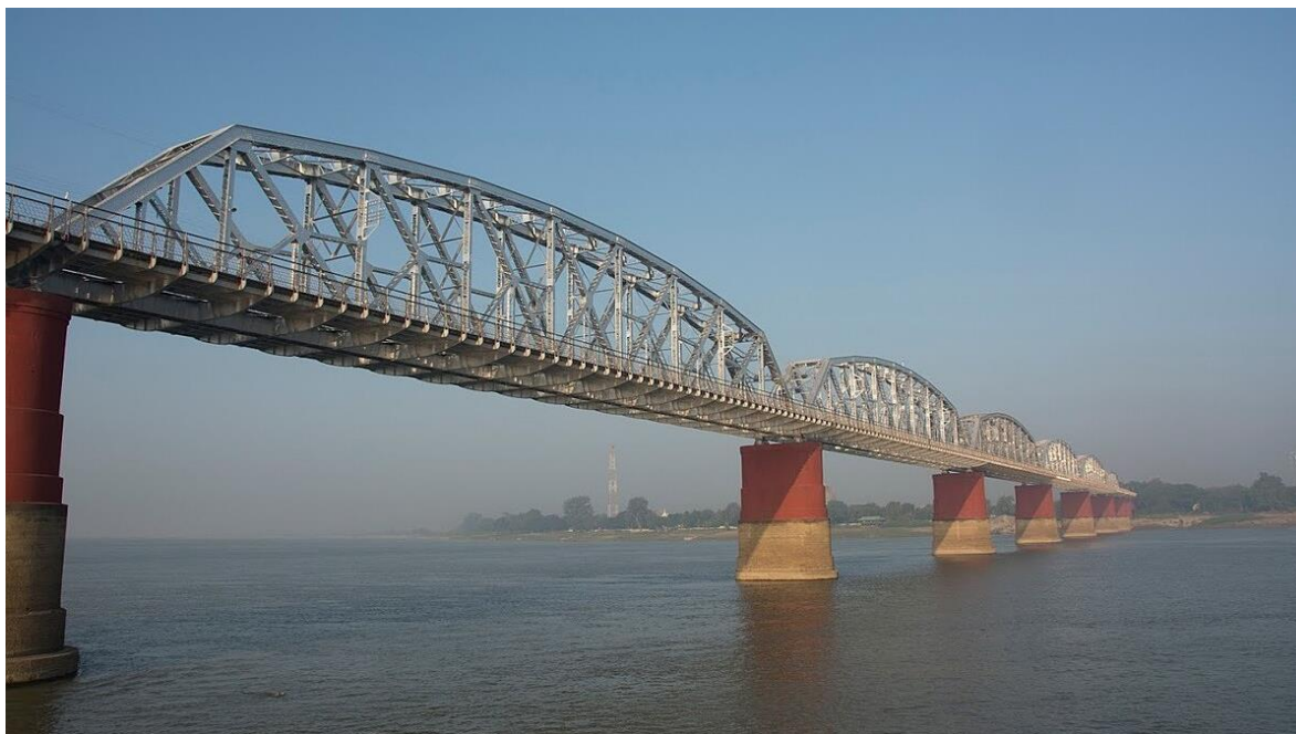
Figura 6.1. Puente Ava antes del terremoto del 28 de marzo de 2025.
