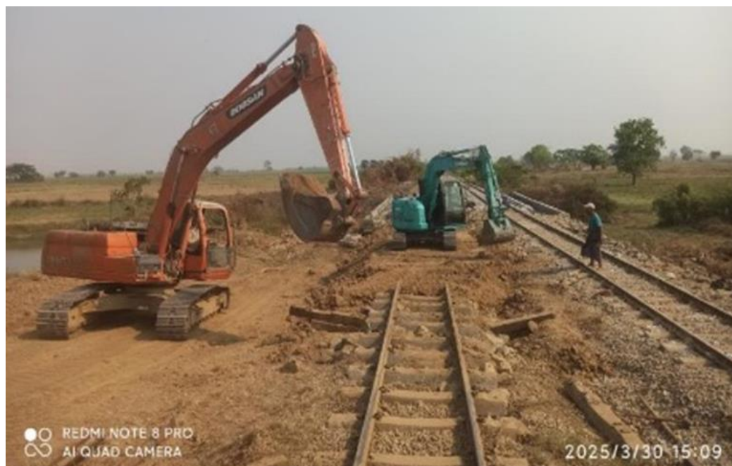
Figura 6.16. Labores de reparación de la red ferroviaria de Myanmar.
