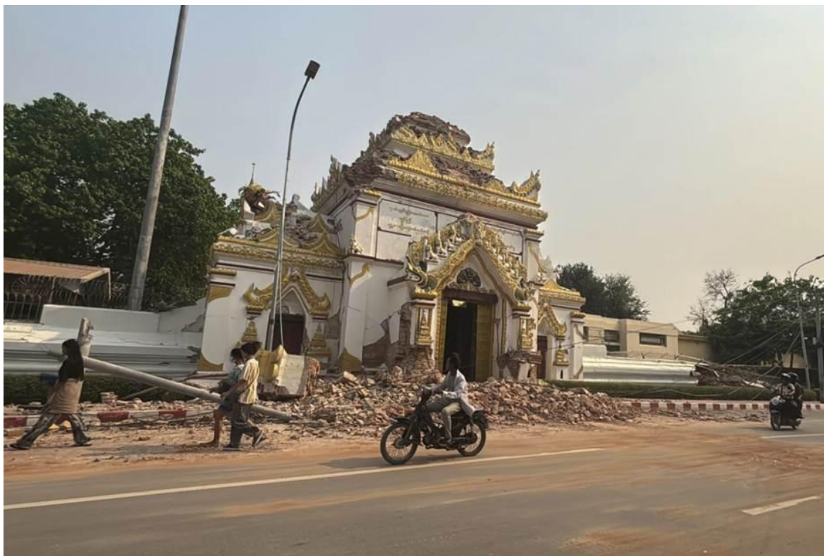
Figura 7.3. Daños en un monumento histórico debidos al terremoto del 28/mar/2025.
