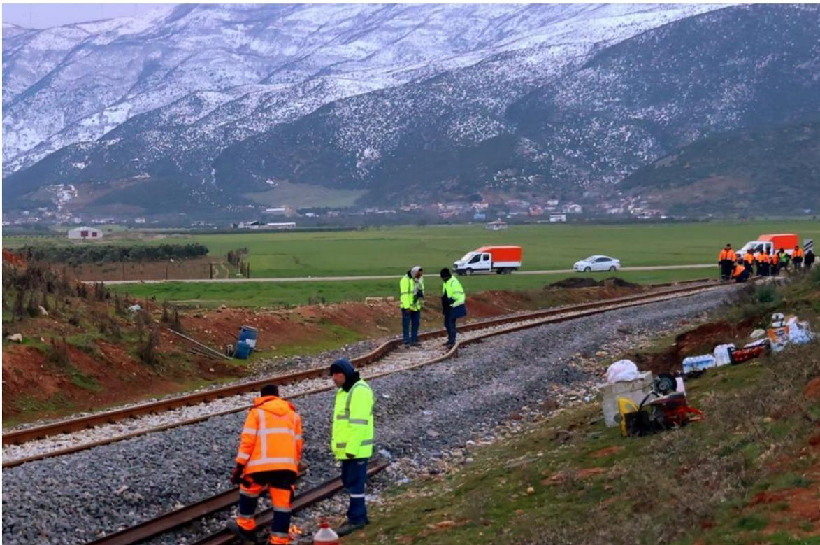
Figura 7.9. Desplazamiento lateral en las vías del tren (Twitter, 2023i).
