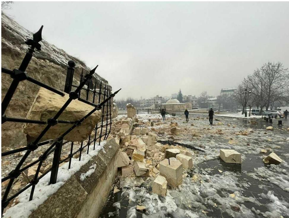
Figura 5.4. Afectaciones derivadas del desprendimiento de material en el Castillo Gaziantep (Treisman, 2023).
