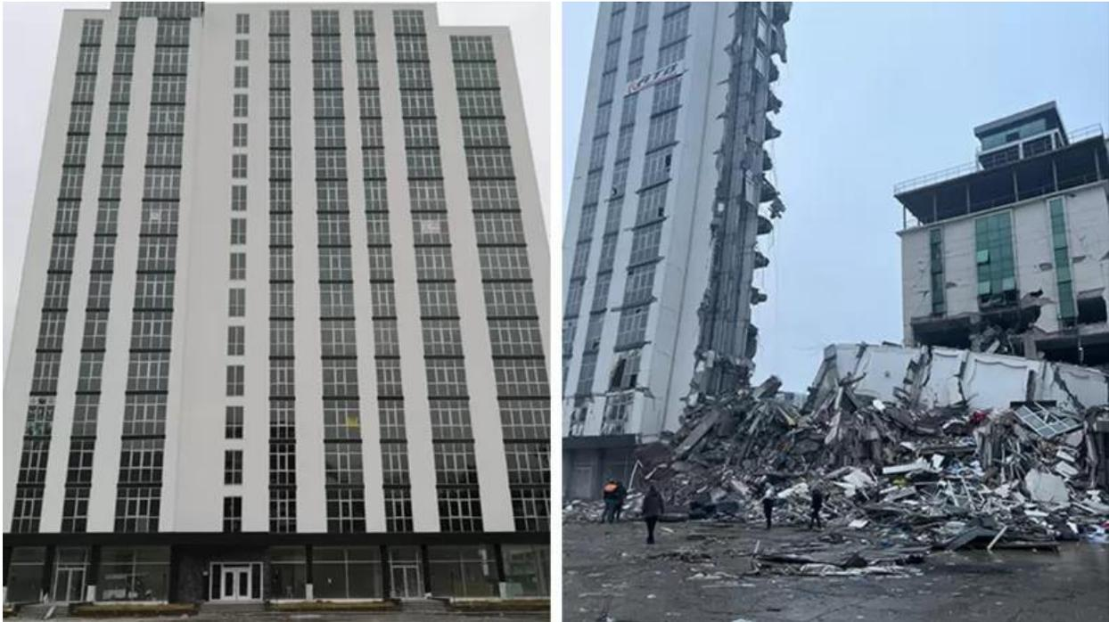
Figura 3.12. Antes y después de un edificio de apartamentos de reciente construcción en Iskanderun (BBC, 2023a).
