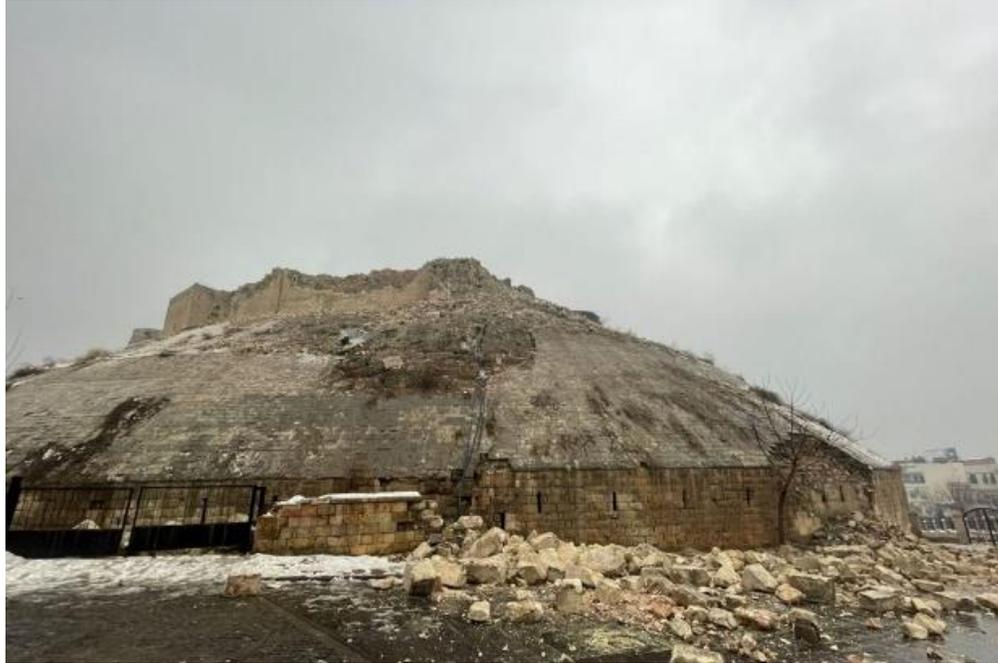
Figura 5.3. Desprendimiento de muros en el Castillo Gaziantep (Cookman, 2023).
