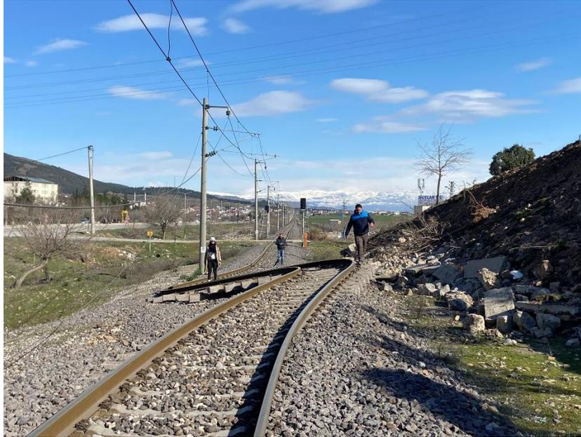
Figura 7.10. Desplazamiento lateral en las vías del tren (Twitter, 2023j).
