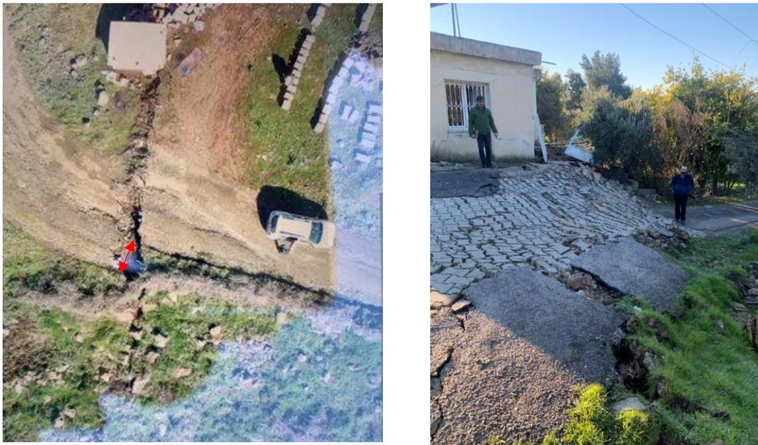
Figura 7.1. Desplazamiento lateral y vertical en el norte de Kırıkhan (Twitter, 2023a).
