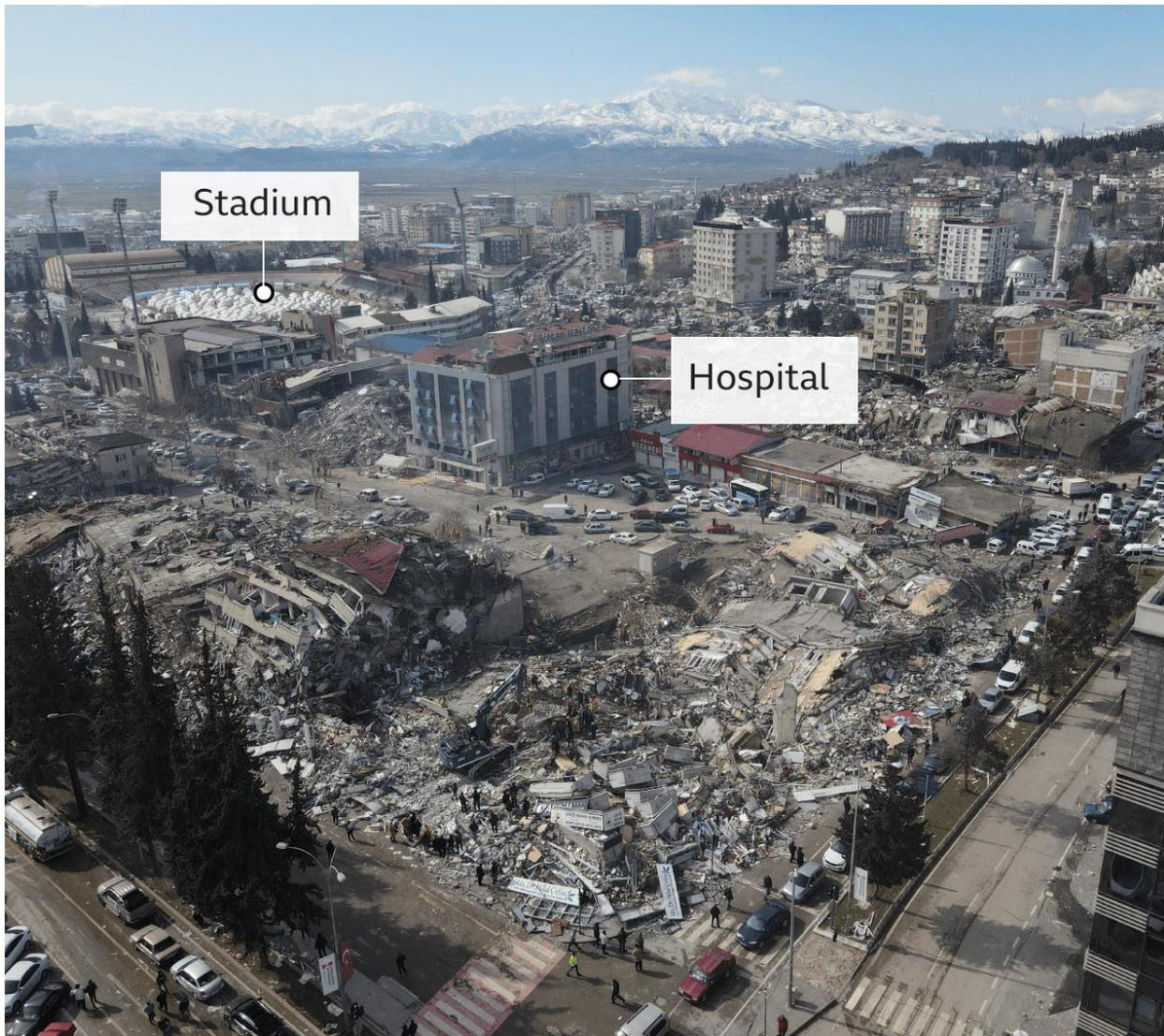
Figura 6.3. El hospital Sular, en Kahramanmaras, Turquía (BBC, 2023). A diferencia de muchas otras construcciones, el hospital sobrevivió a los terremotos, aunque quedó dañado.
